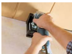
frezowanie rowków dylatacyjnych
