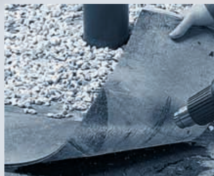
Zgrzewanie papy pokryć dachowych
