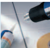
Suszenie fug budowlanych
