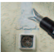
Suszenie tynku na ścianie
