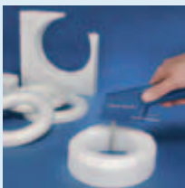
Wykonywanie wierćców ze styropianu
