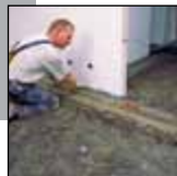
Typ AL 2L-2G: Wyrównywanie materiału jastrycha.
