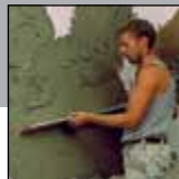
Typ TRK: Obciąganie obrzutki.
