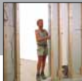
Typ AL 2L: Kontrolowanie słupa ściany.
