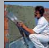
Typ HAK: Wygładzanie powierzchni obrzutki.
