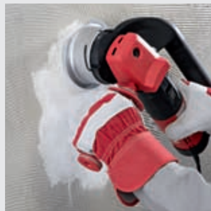
Głowica frezowa z 12 kątami ze stopów twardych szczególnie nadaje się do usuwania starego kleju do płytek.
