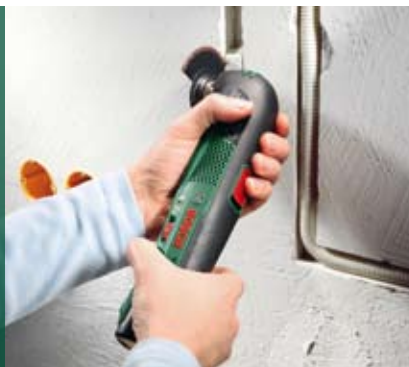
Wycinanie tunelu kablowego.
