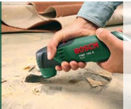
Usuwanie pozostałości po wykładzinach.
