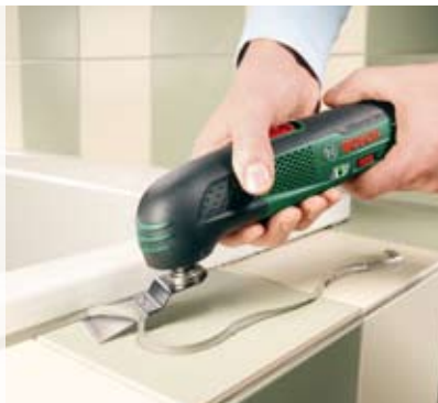
Usuwanie uszczelnień silikonowych.
