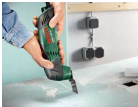
Wycinanie otworów w płycie gipsowo-kartonowej.
