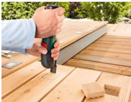
Wycinanie otworów w podłogach tarasowych.
