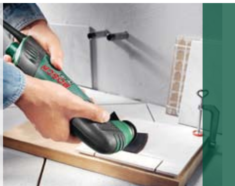
Cięcie płytek ściennych.
