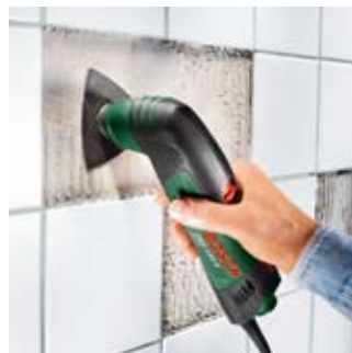
Wyrównywanie podłoża.
